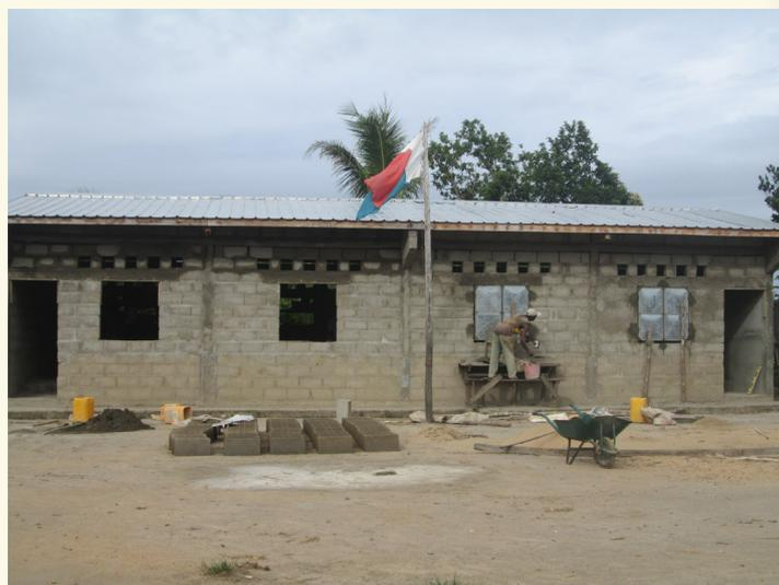
Nous reprenons possession du chantier pour réaliser les « finitions » de notre nouvelle école de brousse : séparations des classes en agglos, pose des menuiseries, enduit intérieur et extérieur.
