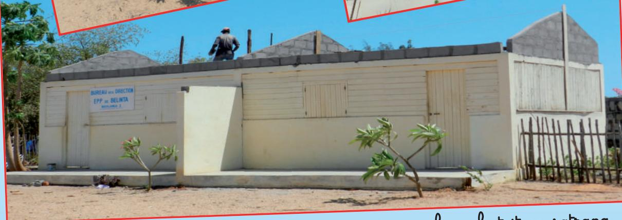
Pour y remédier, nous avons décidé de remplacer le toit en satrana par du bac acier et réhausser les pignons pour augmenter la pente et ainsi favoriser l'écoulement de l'eau.
