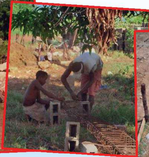
● Ferrailage fabriqué à la main
