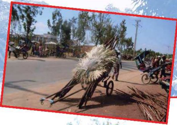
● Transport matériaux couverture
