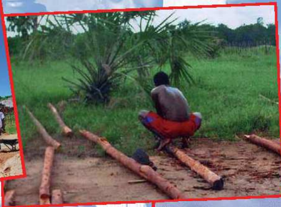
● taille des bois de mangrove pour la charpente selon procédés traditionnels
