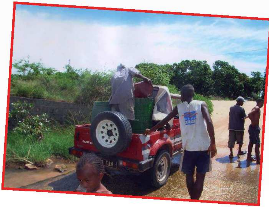
● Provision d'eau à la rivière pour la construction
