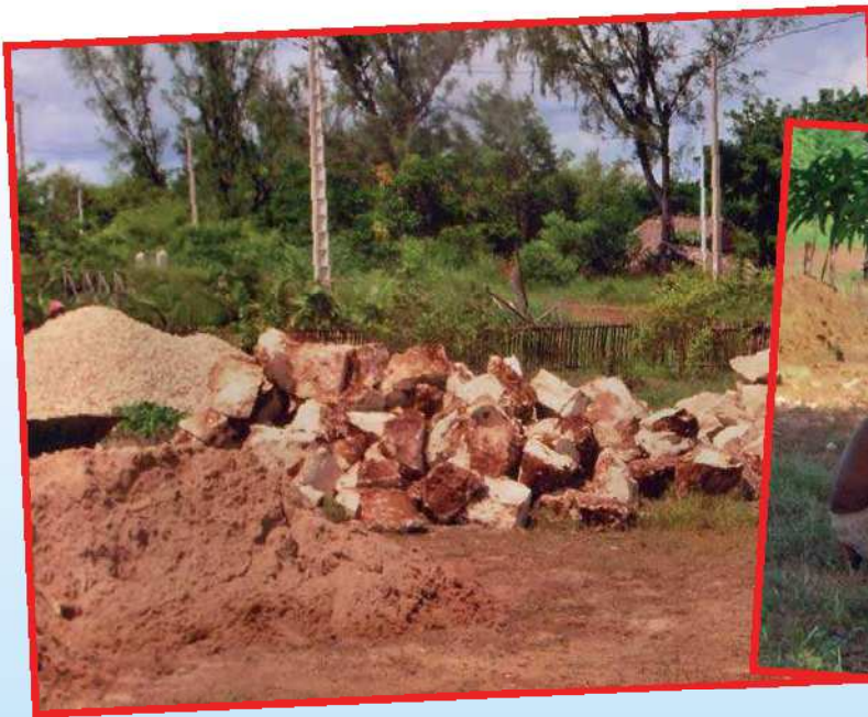
● Matériaux pour les fondations : moellons, sables, graviers
